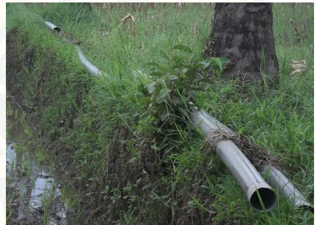
Gambar 4. Pipa untuk mengairi air ke lahan
