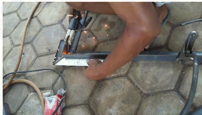
Gambar C.4 Proses penguncian rangka siku menggunakan las listrik
