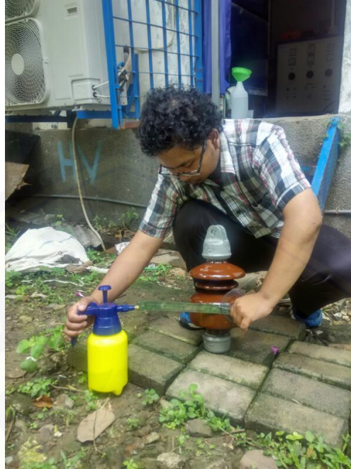
Gambar 3.2 Proses Penyemprotan Isolator Tarik
