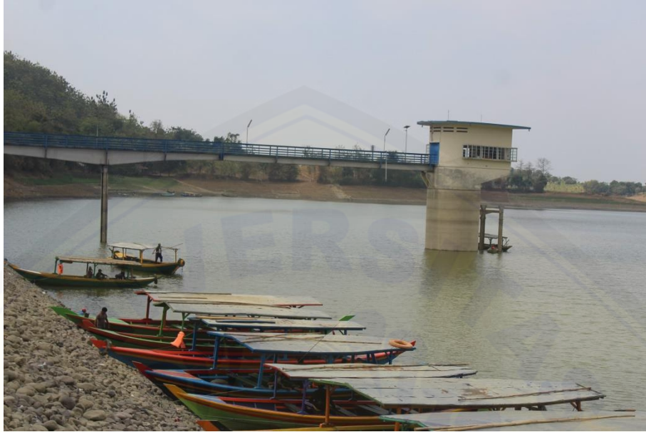
Menara pengatur air Waduk Cacaban.
