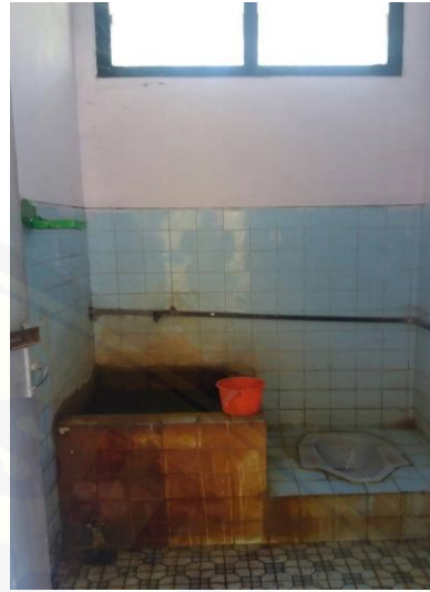
Gambar 2. Toilet dengan ventilasi > 10% luas lantai
