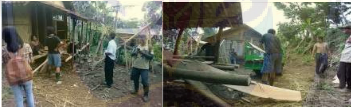
Gambar 6. Proses pembangunan dan renovasi lokasi baru bagi basecamp komunitas Sokola Kaki Gunung. Setelah pembangunan lokasi baru ini, maka para tenaga pengajar tidak lagi menggunakan tempat / rumah Gus Farid.
