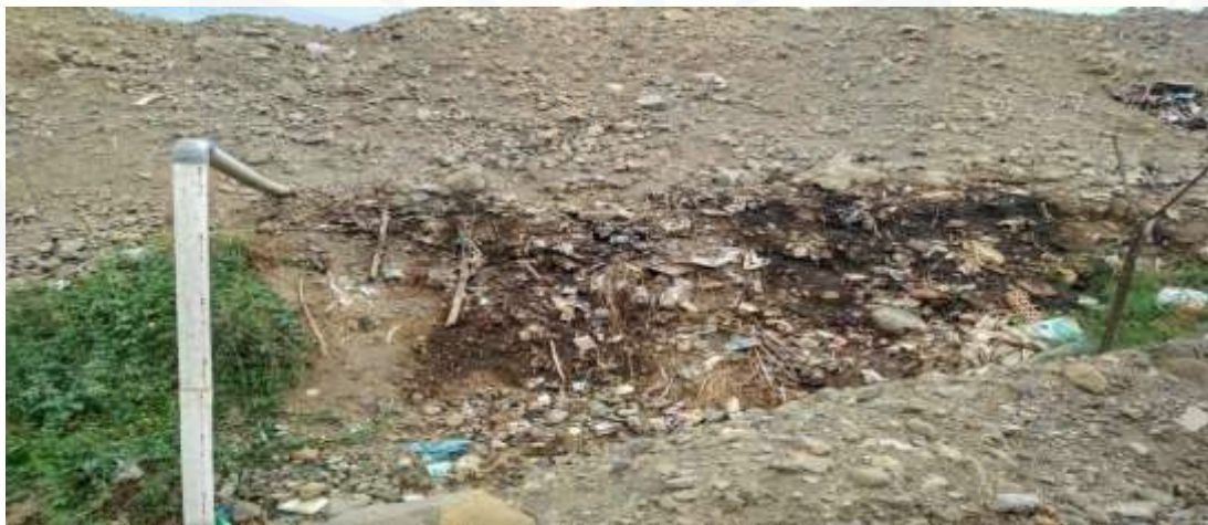
Gambar 2.2. Pipa saluran lindi dan bukti keberadaan rembesan air lindi
