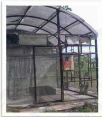
Kondisi Green House
