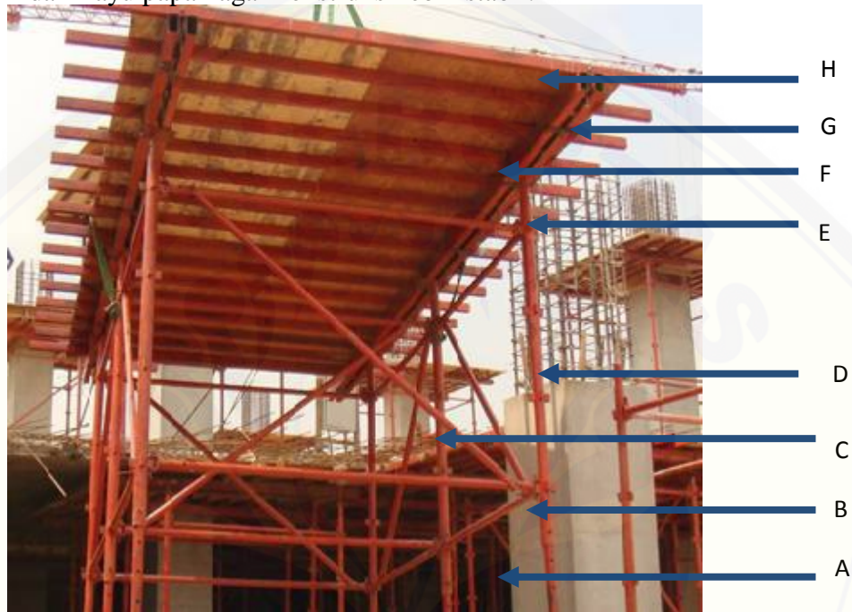
Gambar 2.2 Sketsa komponen bekisting table form plat
