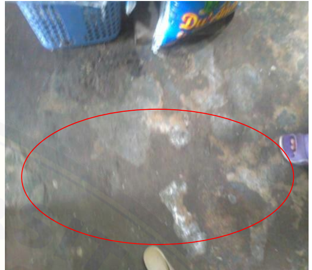
Gambar 4.6 Salah satu contoh komponen rumah berupa lantai plester dengan keadaan berlubang
