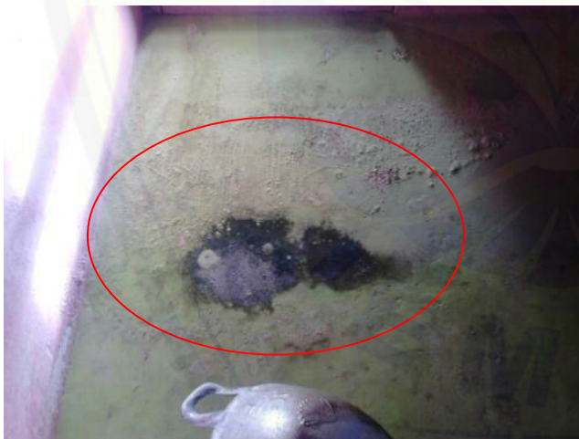
Gambar 4.3 Salah satu contoh komponen rumah berupa dinding dengan keadaan lembab
