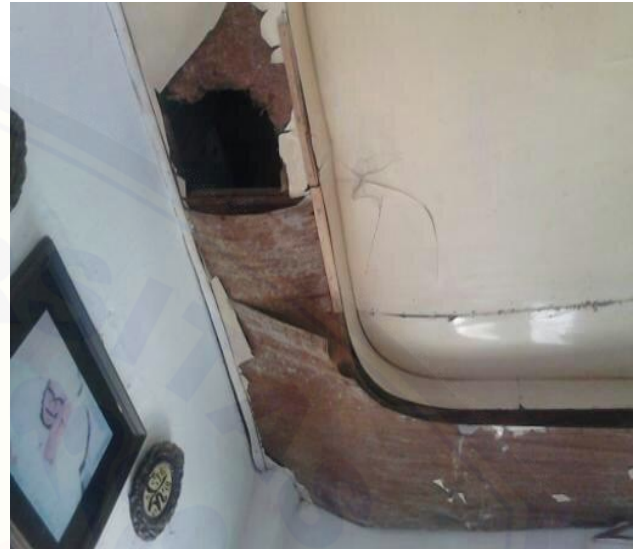
Gambar 4.2 Salah satu contoh komponen rumah berupa langit-langit dengan keadaan rusak
