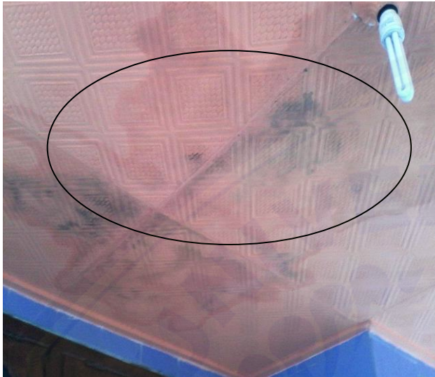
Gambar 4.1 Salah satu contoh komponen rumah berupa langit-langit yang terdapat bercak rembesan air
