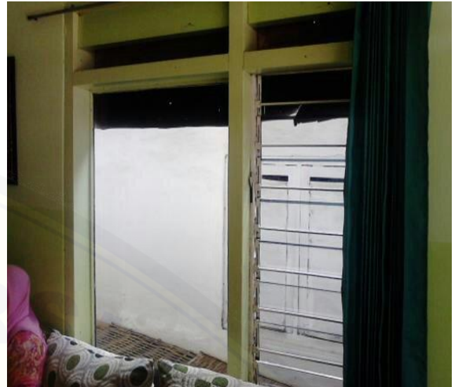
Gambar 4.10 Salah satu contoh komponen rumah berupa jendela pasif dan aktif serta ventilasi
