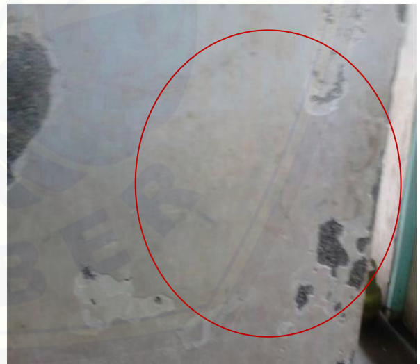
Gambar 4.4 Salah satu contoh komponen rumah berupa dinding dengan keadaan cat terkelupas
