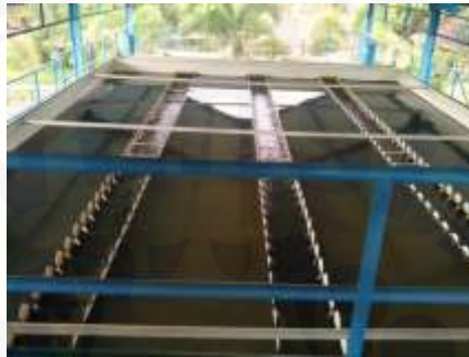
Gambar 2.4 Tempat proses sedimentasi
