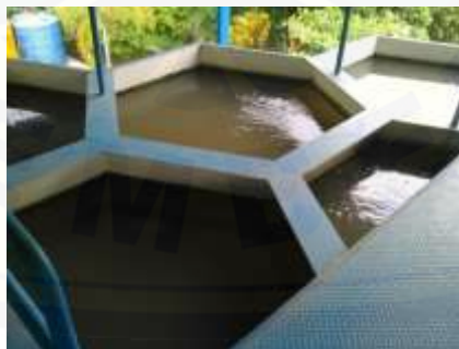
Gambar 2.3 Tempat proses flokulasi
