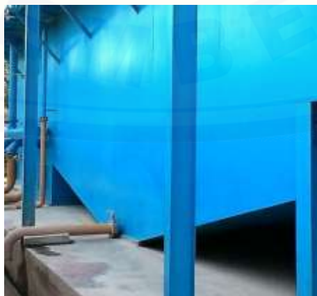
Gambar 3.11 Bangunan asli bak sedimentasi PDAM Jember
