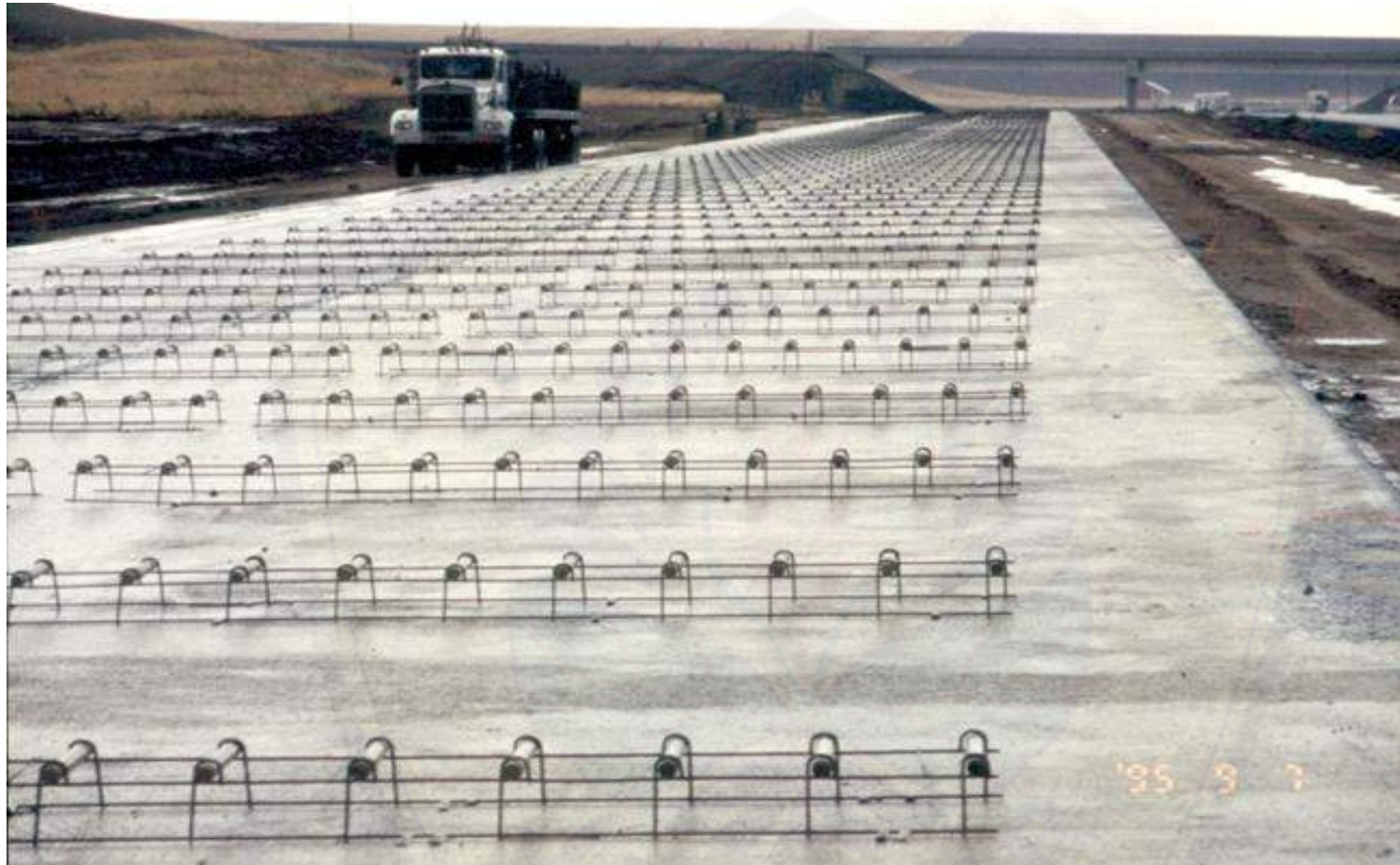
Gambar 5.9 Pemasangan Dowel
