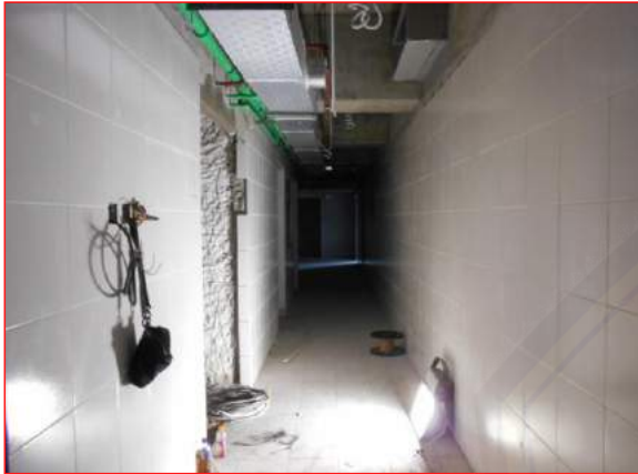
Pekerjaan dinding bata ringan LANTAI 5
