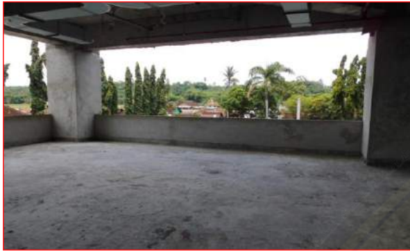
Pekerjaan dinding bata ringan LANTAI 1
