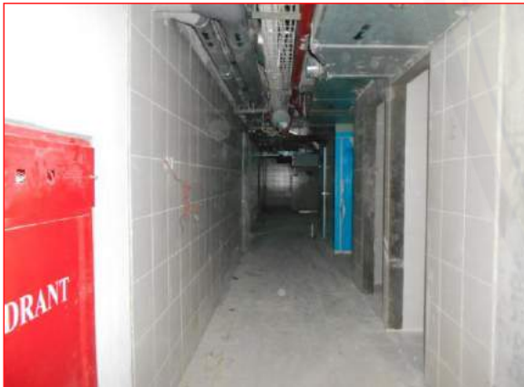
Pekerjaan dinding bata ringan LANTAI 5
