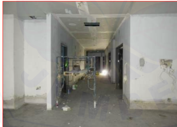
Pekerjaan dinding bata ringan LANTAI 6
