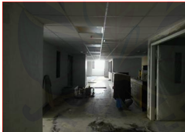
Pekerjaan dinding bata ringan LANTAI 8
