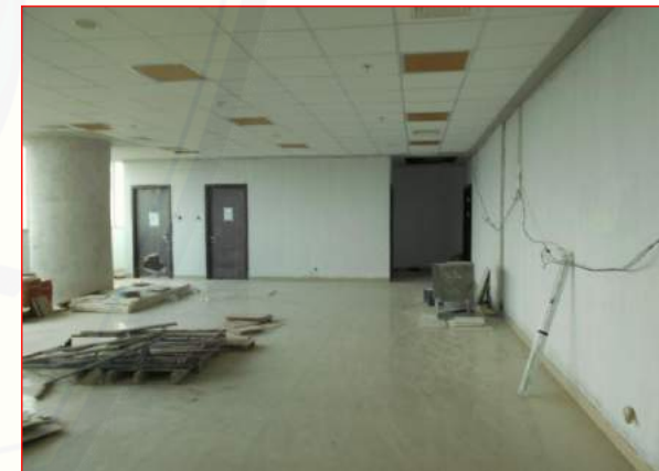
Pekerjaan dinding bata ringan LANTAI 6
