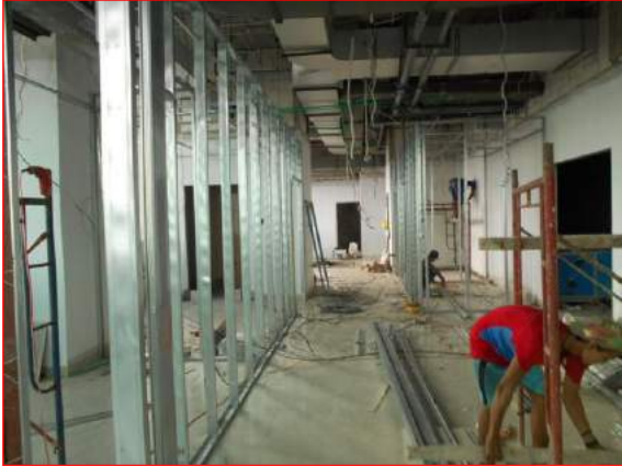
Pekerjaan dinding bata ringan LANTAI 6
