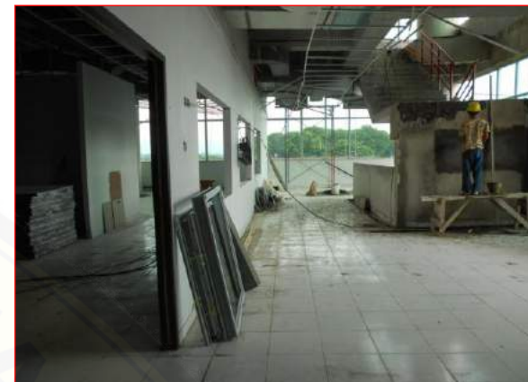
Pekerjaan dinding bata ringan LANTAI mezz 2
