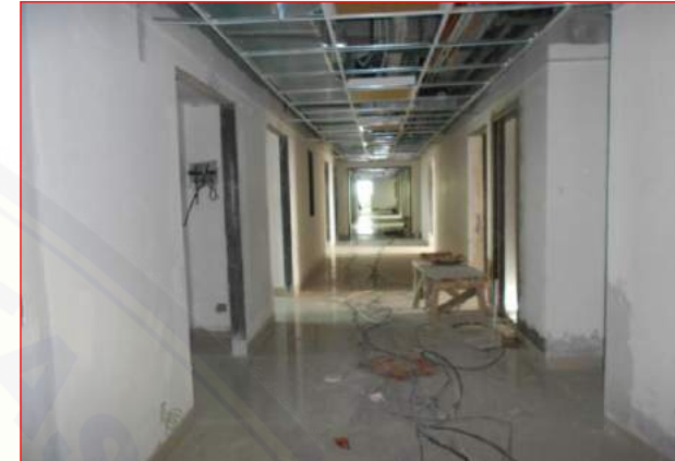
Pekerjaan dinding bata ringan LANTAI 8
