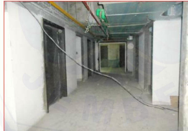
Pekerjaan expose LANTAI 5
