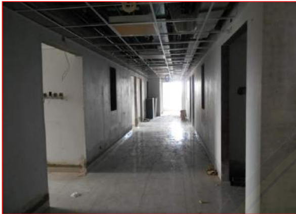
Pekerjaan dinding bata ringan LANTAI 8
