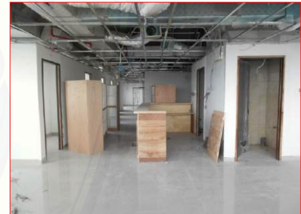
Pekerjaan dinding bata ringan LANTAI 7
