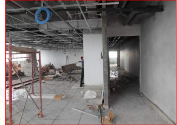
Pekerjaan dinding bata ringan LANTAI 7
