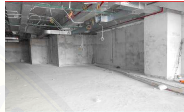
Pekerjaan dinding bata ringan LANTAI 1
