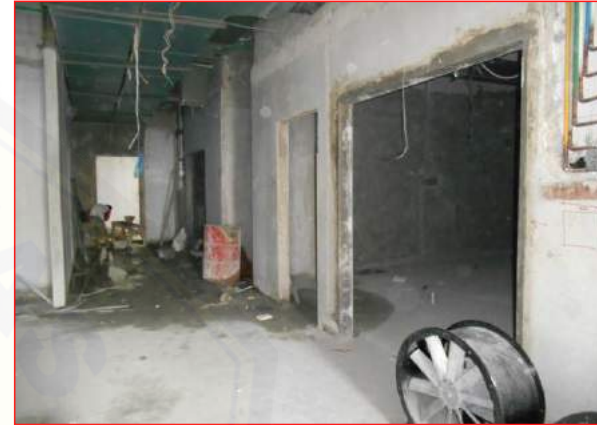
Pekerjaan dinding bata ringan LANTAI 6
