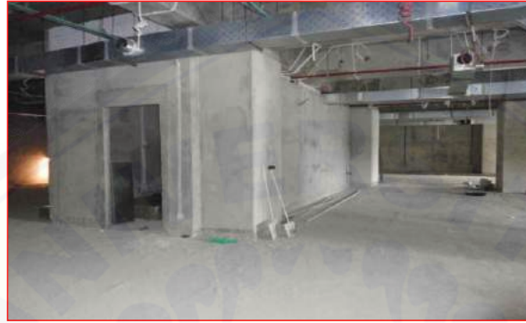
Pekerjaan dinding bata ringan LANTAI 1
