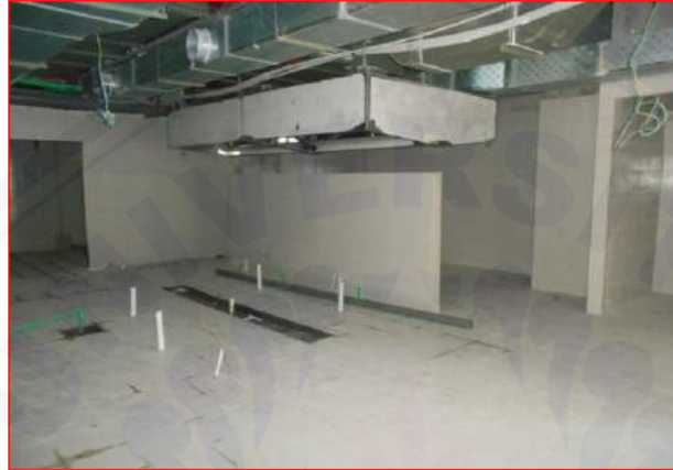
Pekerjaan dinding bata ringan LANTAI 5
