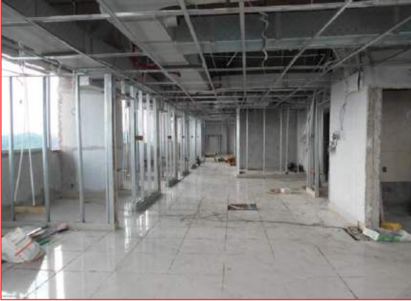
Pekerjaan dinding bata ringan LANTAI 7
