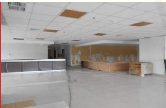
Pekerjaan dinding bata ringan MEZZANINE 1
