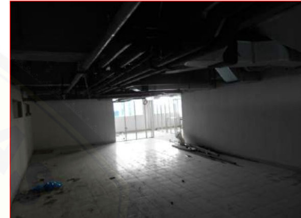
Pekerjaan dinding bata ringan LANTAI 5
