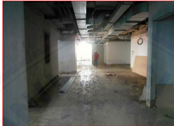
Pekerjaan dinding bata ringan LANTAI 9
