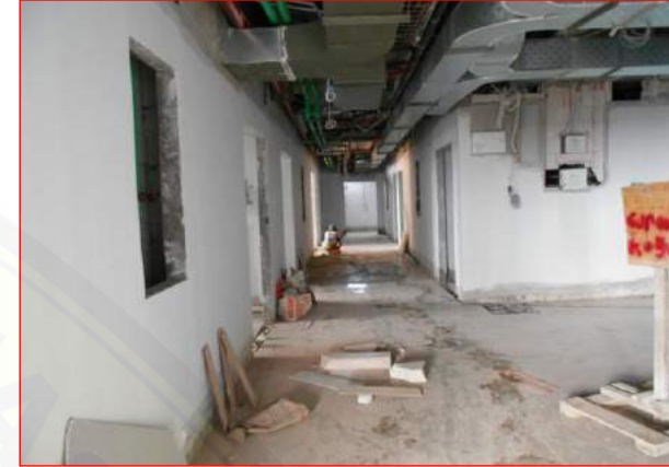
Pekerjaan dinding bata ringan LANTAI 9
