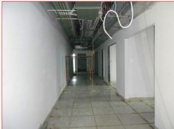
Pekerjaan dinding bata ringan LANTAI 7
