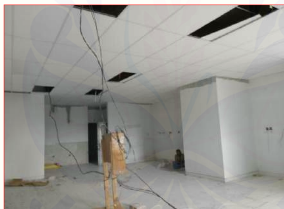
Pekerjaan dinding bata ringan LANTAI mezz 2
