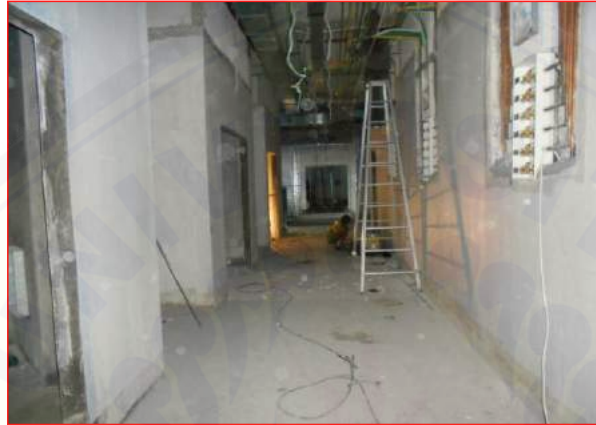
Pekerjaan dinding bata ringan LANTAI 6
