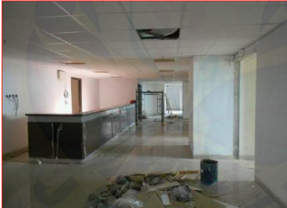
Pekerjaan dinding bata ringan LANTAI 9
