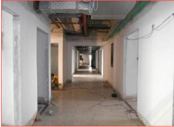
Pekerjaan dinding bata ringan LANTAI 9
