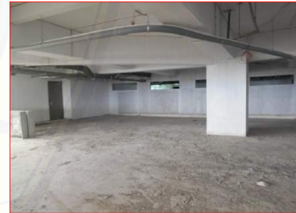
Pekerjaan expose LANTAI 5
