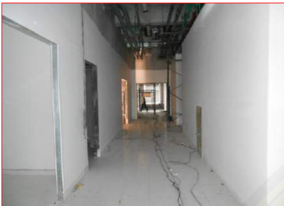
Pekerjaan dinding bata ringan LANTAI mezz 2
