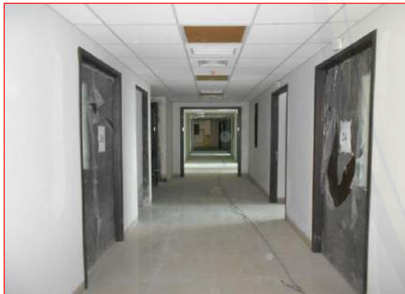
Pekerjaan dinding bata ringan LANTAI 8
