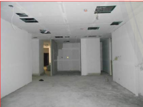
Pekerjaan dinding bata ringan LANTAI 6
