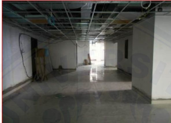
Pekerjaan dinding bata ringan LANTAI 8
