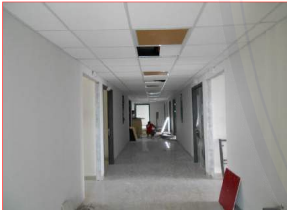
Pekerjaan dinding bata ringan LANTAI 9
