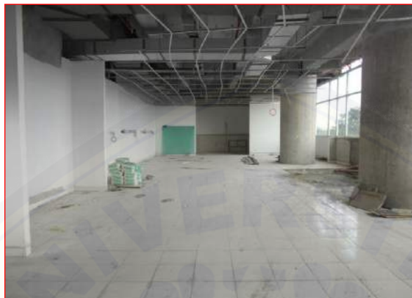
Pekerjaan dinding bata ringan LANTAI mezz 2
