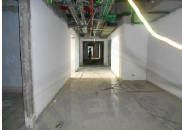
Pekerjaan dinding bata ringan LANTAI 7
