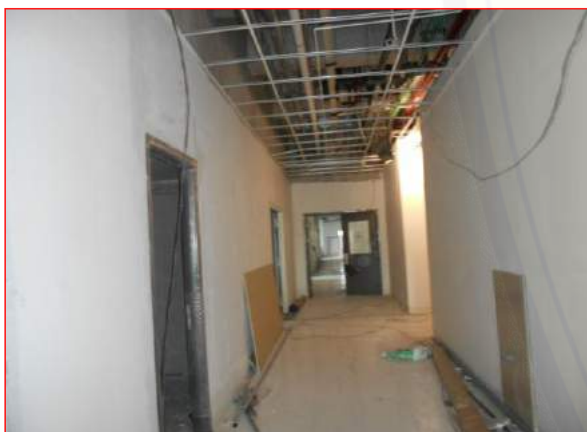
Pekerjaan dinding bata ringan LANTAI mezz 2
