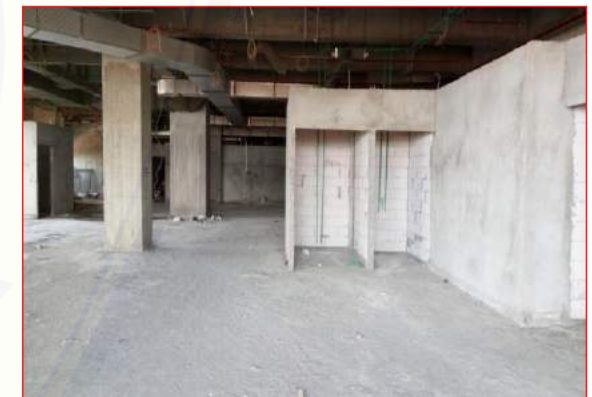
Pekerjaan dinding bata ringan LANTAI 1
