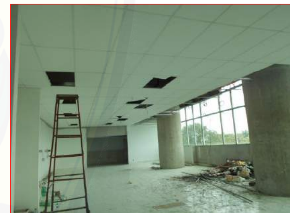
Pekerjaan dg bata ringan LANTAI mezz 2
