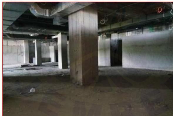
Pekerjaan dinding bata ringan LANTAI 1
