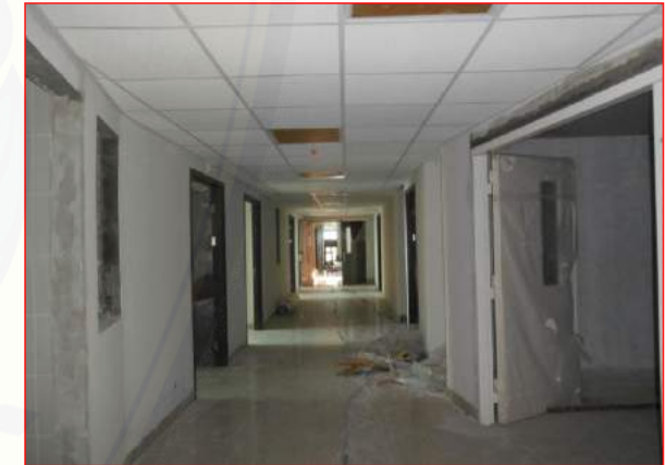
Pekerjaan dinding bata ringan LANTAI 9
