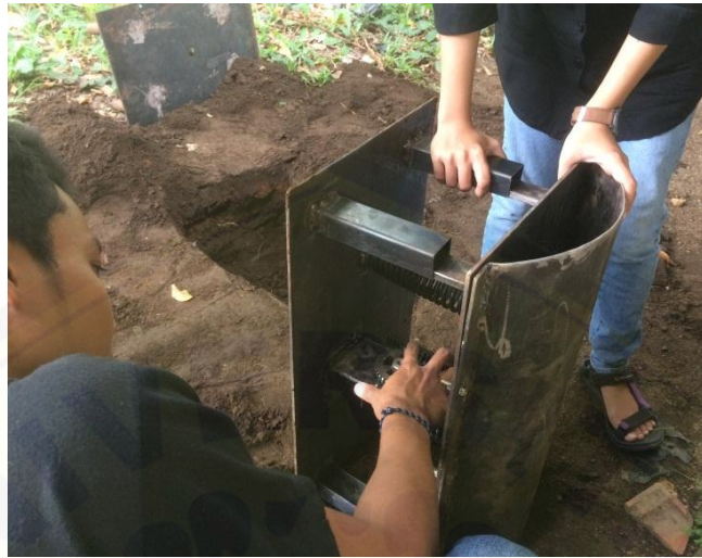
Gambar C.7 Proses pemasangan pada lubang
