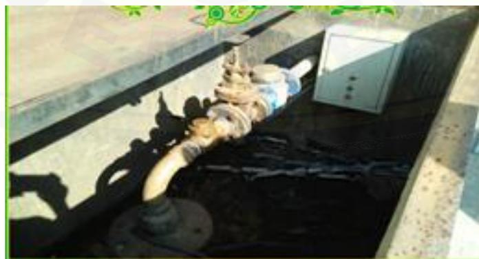
Gambar B.5 Pompa Submersible Sumur 1
