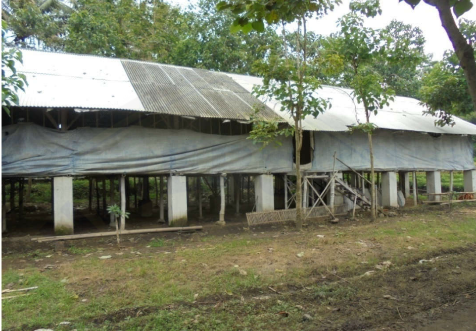
Gambar 1. Kandang yang menggunakan asbes sebagai atap
