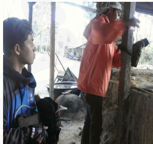
Gambar 8. Proses Pemasangan Alat
