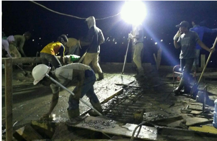
Pekerjaan Pengecoran
