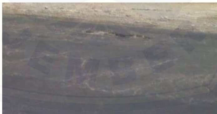
Gambar 2.6 Retak sambungan
