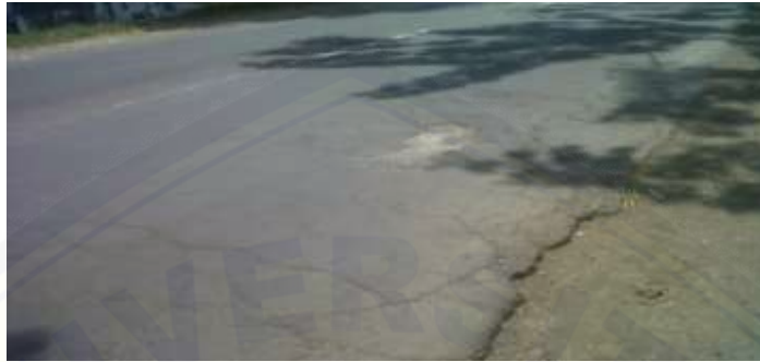
Gambar 2.3 Retak pinggir
