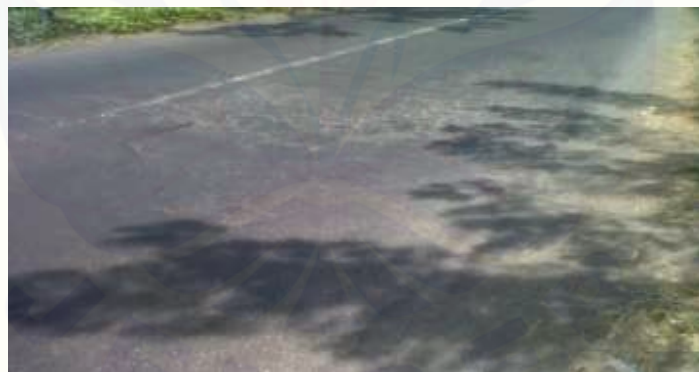
Gambar 2.2 Retak kulit buaya
