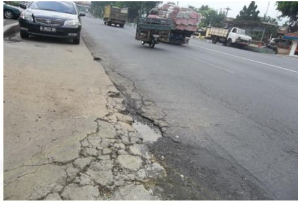
Gambar 2.5 Retak Pinggir
