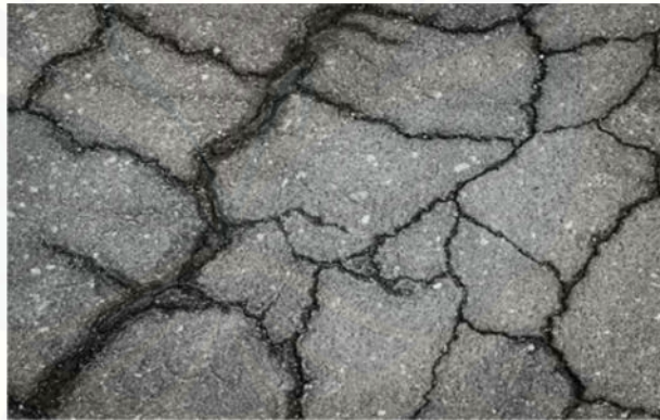
Gambar 2.4 Retak kulit Buaya
