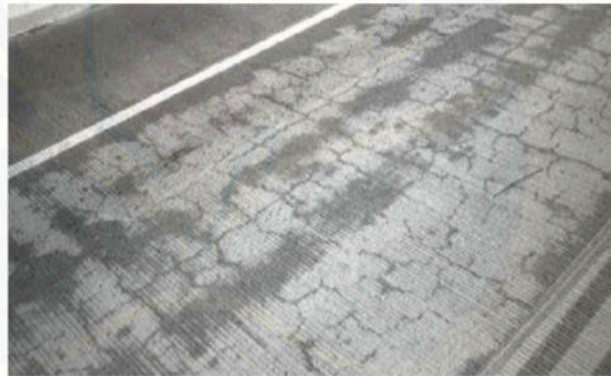
Gambar 2.10 Retak Susut
