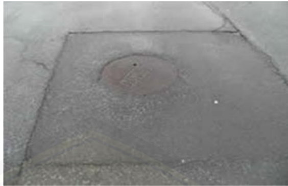
Gambar 2.23 Penurunan pada bekas penanaman ( utility cut depression )
