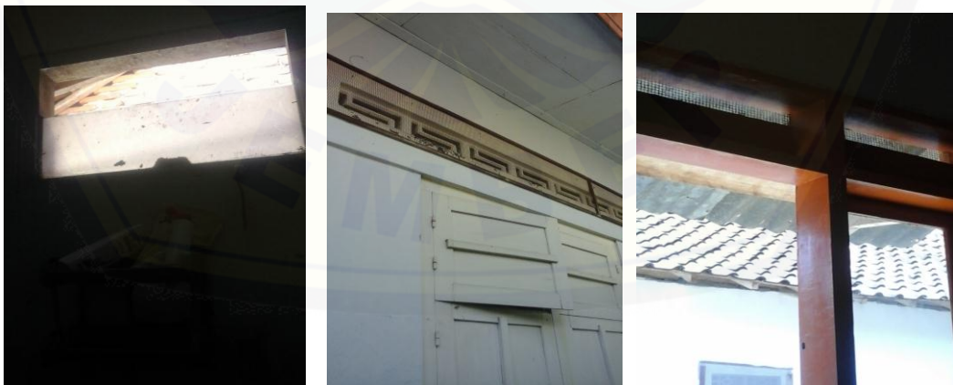
Gambar 8. Ventilasi rumah dan kamar mandi tanpa dan atau menggunakan kawat kasa
