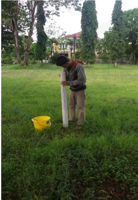
Pemasangan alat uji permeabilitas
