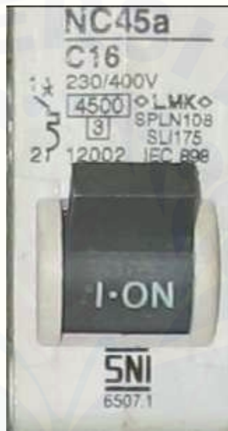
Gambar 2.2 Kode dan Simbol MCB ( www.instalasilistrikrumah.com )
