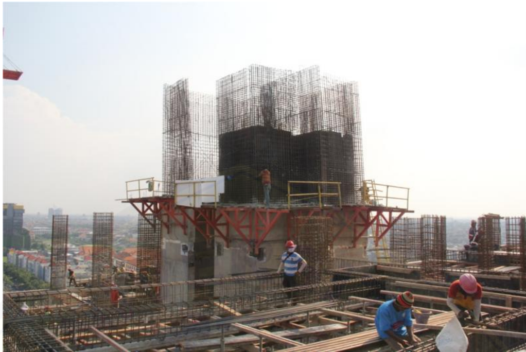
Pemasangan Kolom Struktur
