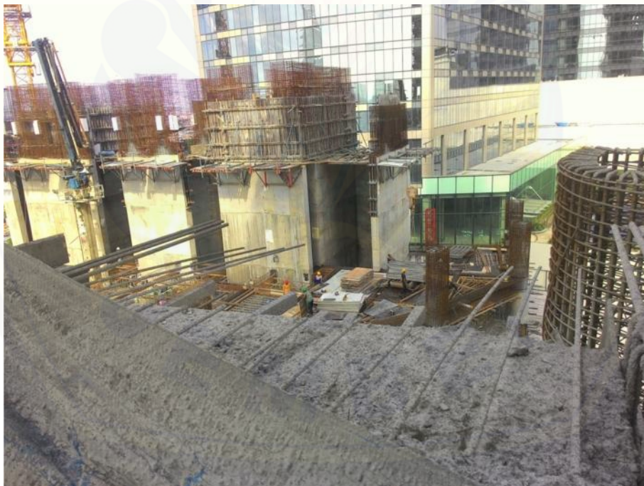
Tulangan salah salah satu jenis kolom pada TP 6 Surabaya
