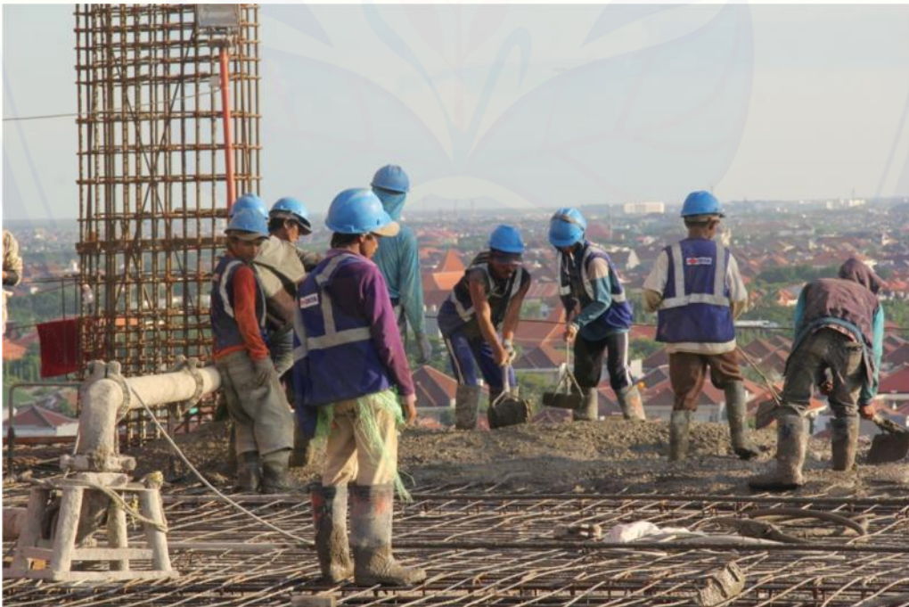
Pengecoran Plat
