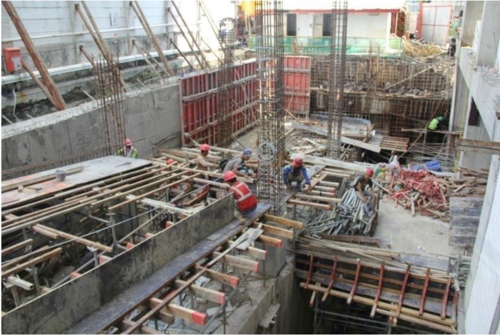
Pemasangan Bekisting pada dinding dan plat
