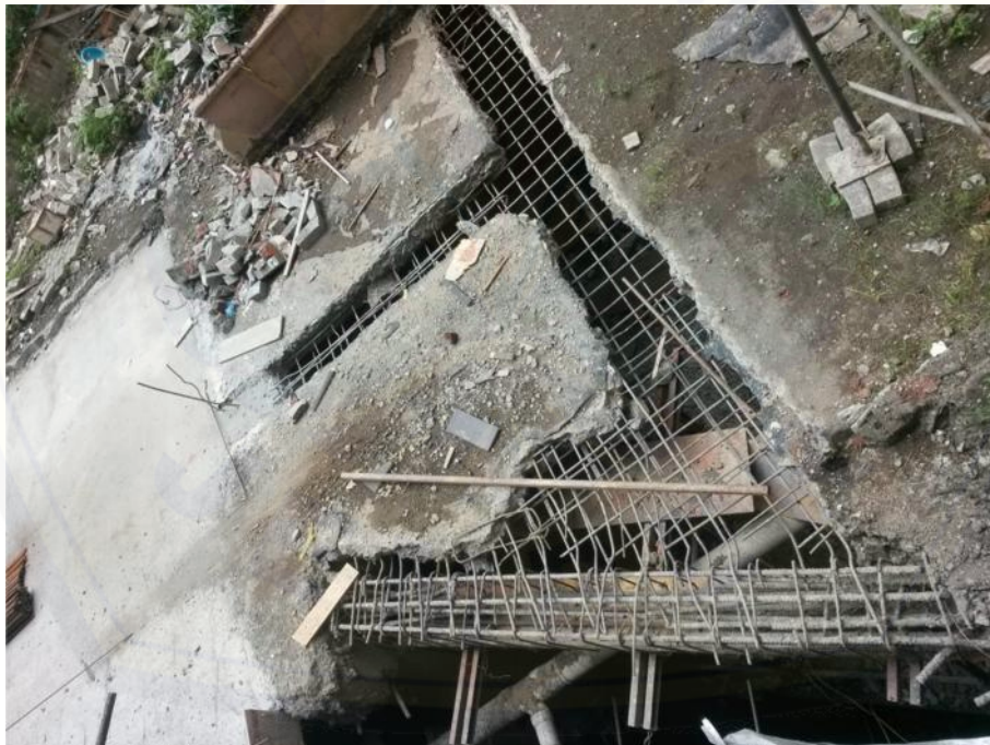
Tampak Tulangan Balok Proyek Pembangunan TP 6 Surabaya
