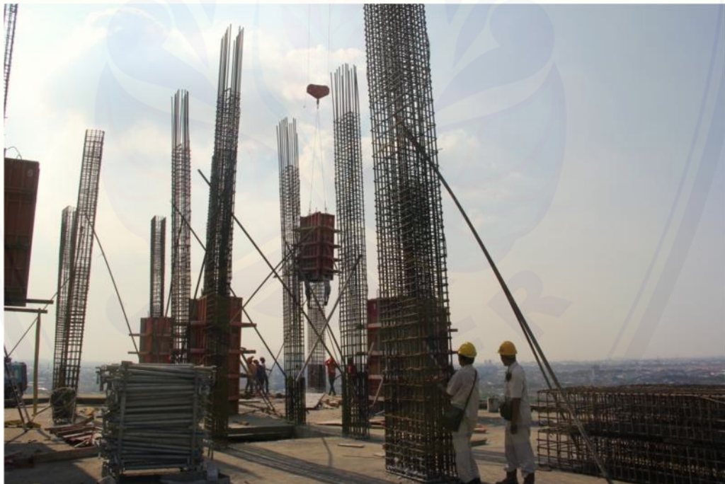
Inspeksi Tulangan dan Bekisting Kolom
