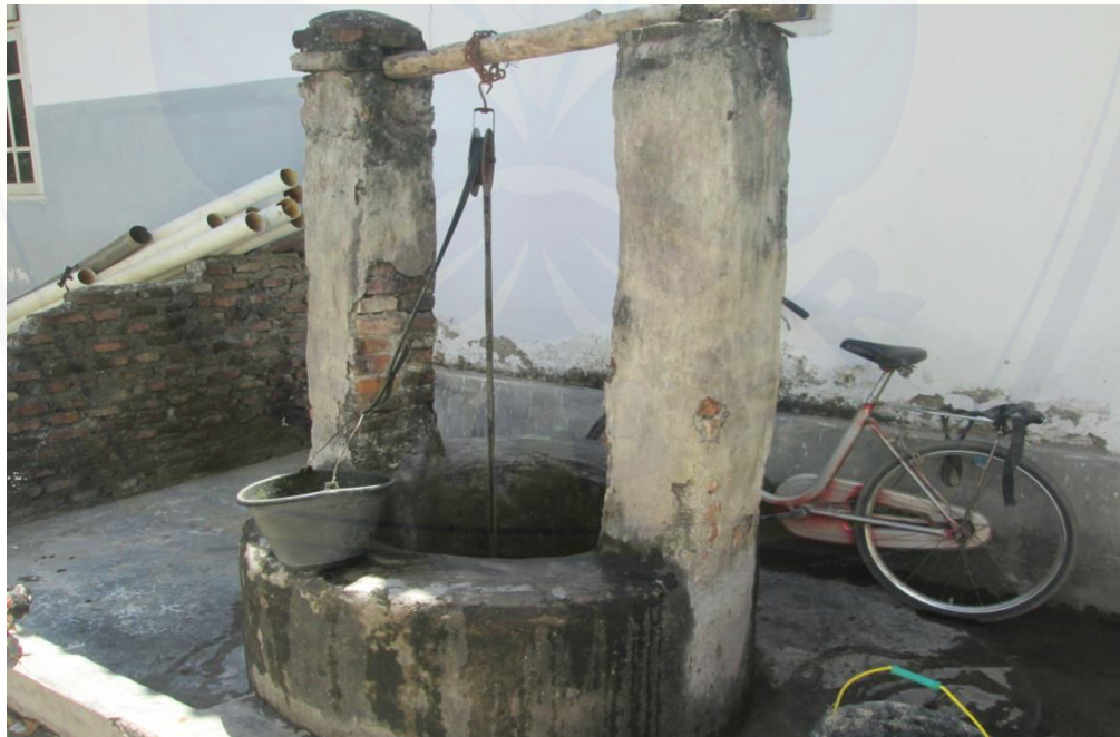
Gambar 10, kondisi sumur buruh 4 berinisial D
