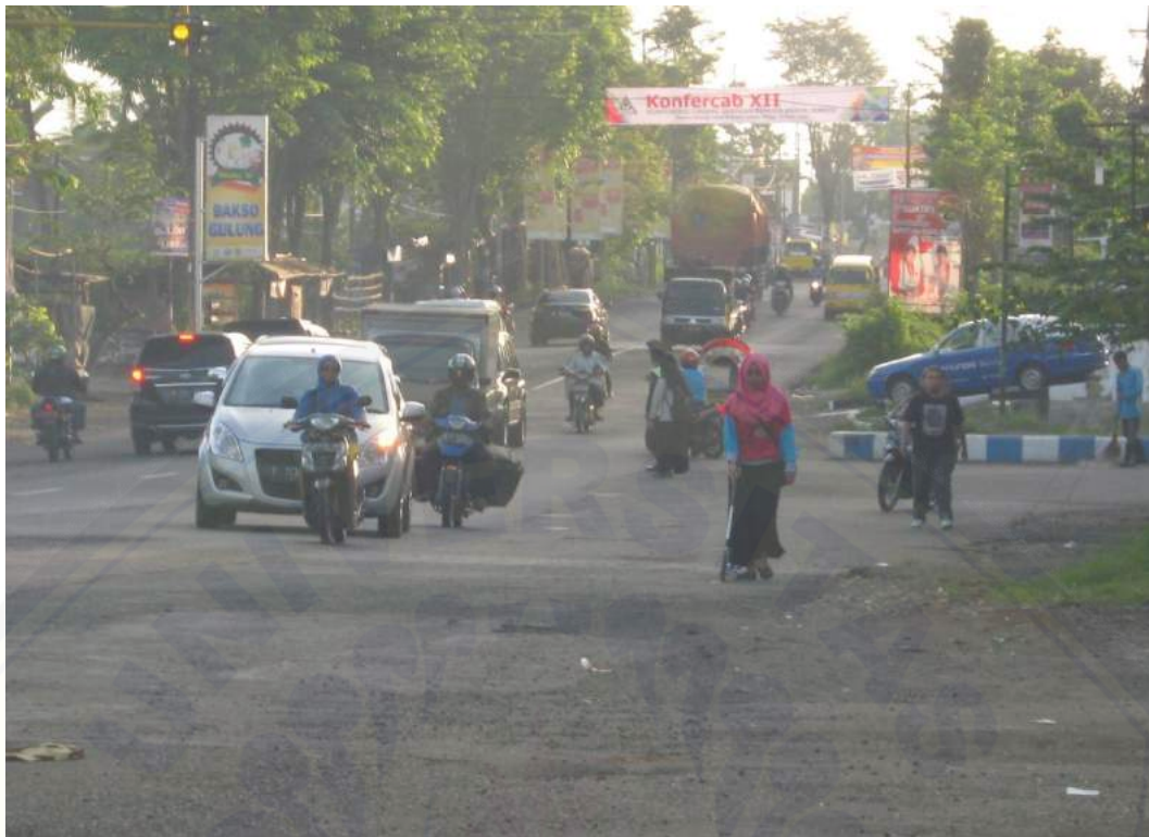
Pengukuran Panjang Jalan
