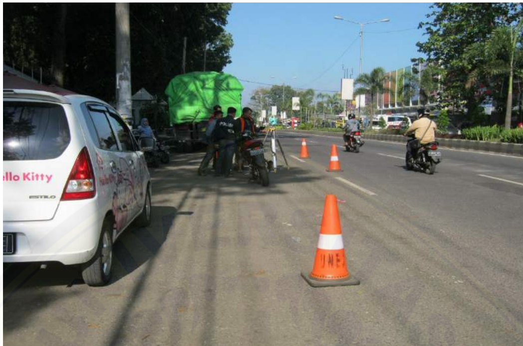
Survey Pemetaan menggunakan Total Station
