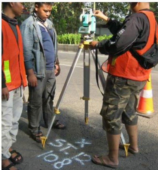
Survey Pemetaan menggunakan Total Station
