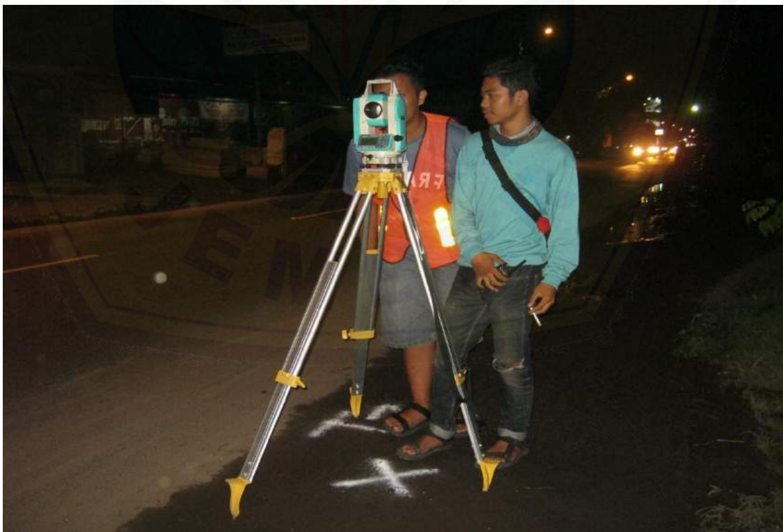
Survey Pemetaan menggunakan Total Station
