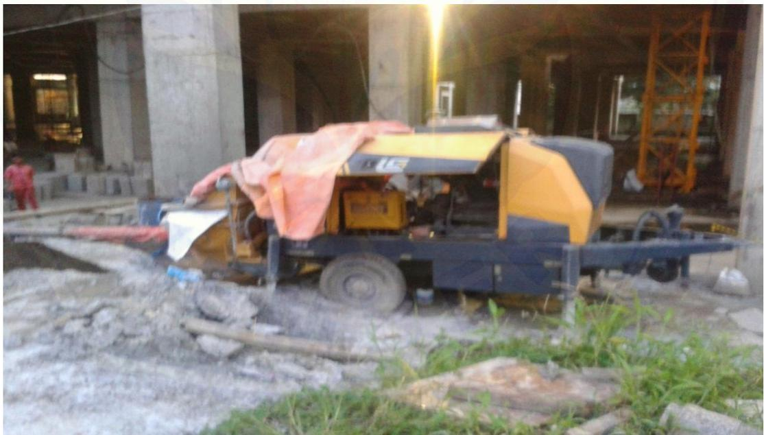
Gambar 1.4 Persiapan Pengecoran Alat Pompa Kodok
