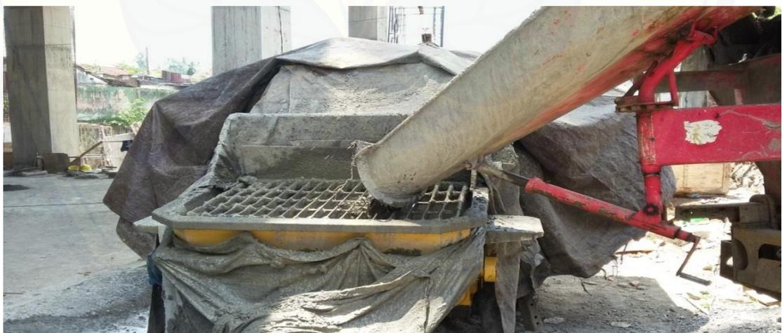
Gambar 1.2 Penuangan beton ready mix dari truck mixer ke pompa kodok
