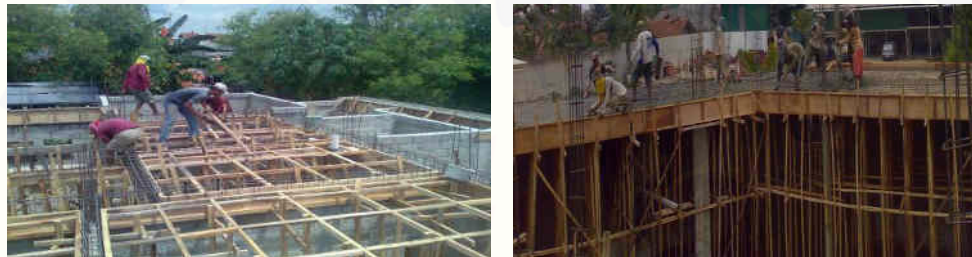
Gambar 2.4 Material Penopang Bekisting dari Kayu
