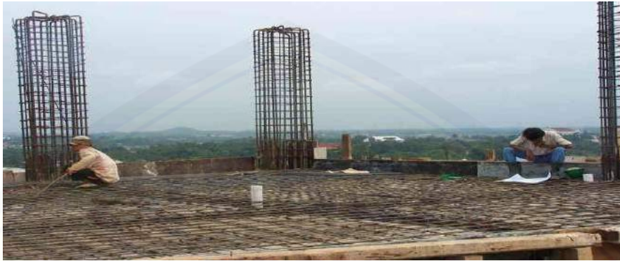
Gambar 2.12 Area kerja (balok & pelat) siap cor setelah pemasangan bekisting dan pembesian.
