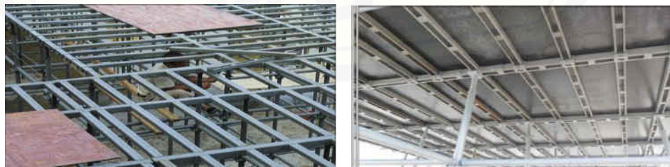
Gambar 2.5 Material Penopang Bekisting dari Baja
