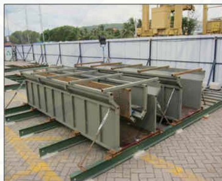
(b) Bekisting Balok Precast
