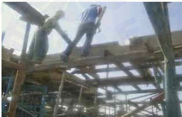
Gambar 2.2 Material Kayu untuk Bekisting
