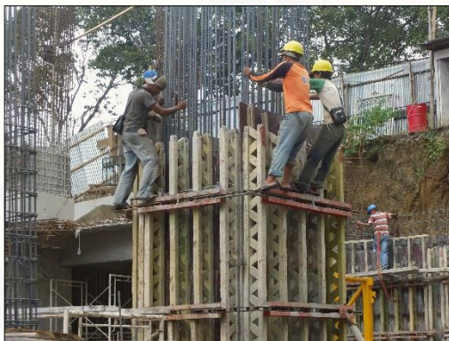
Pelaksanaan Pemasangan Bekisting dengan bantuan Tower Crane
