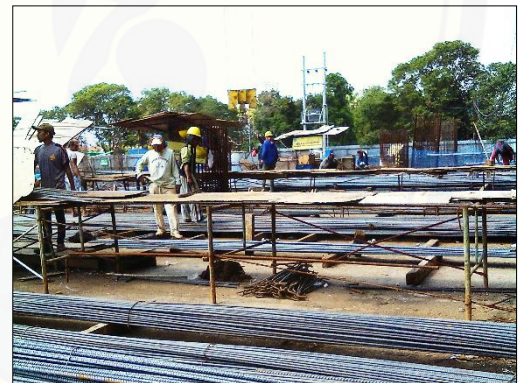
Pelaksanaan Pekerjaan Pabrikasi Pembesian
