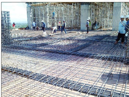
Pelaksanaan Pemasangan Pembesian pada Pelat dan Kolom
