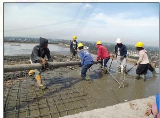
Pelaksanaan Pekerjaan Pengecoran pada Pelat dan Kolom
