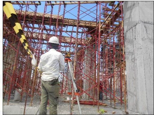
Pelaksanaan Pekerjaan Bekisting pada Pelat Lantai dan Balok
