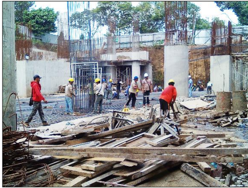
Pelaksanaan Pekerjaan Tulangan pada Pekerjaan kolom
