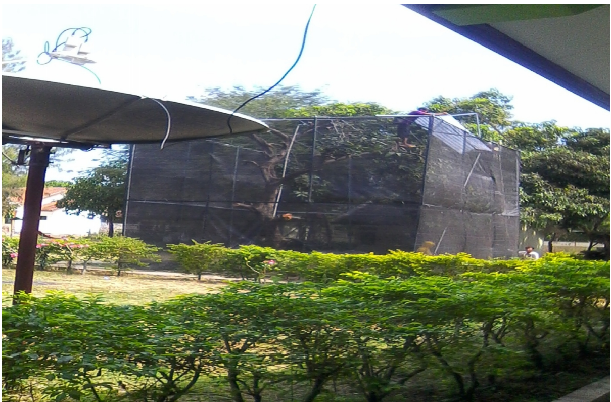
Pemasangan Atap Green House dengan Fiber Glass
