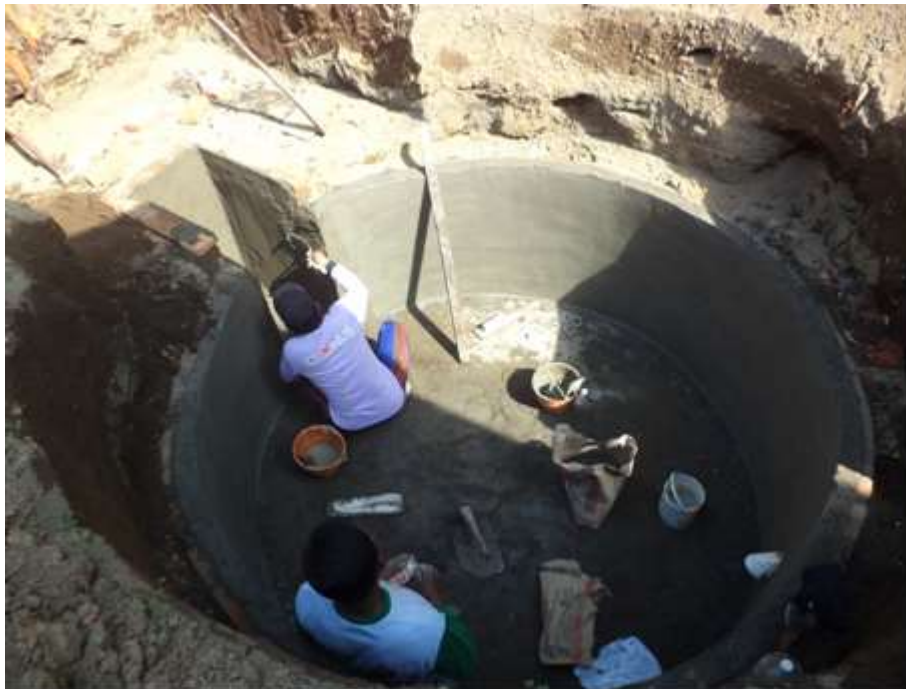
Gambar 13. Pekerjaan Plesterisasi Dinding dan Lantai Reaktor
