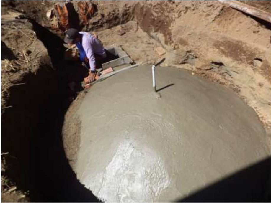
Gambar 14. Pekerjaan Plesterisasi Kubah Reaktor
