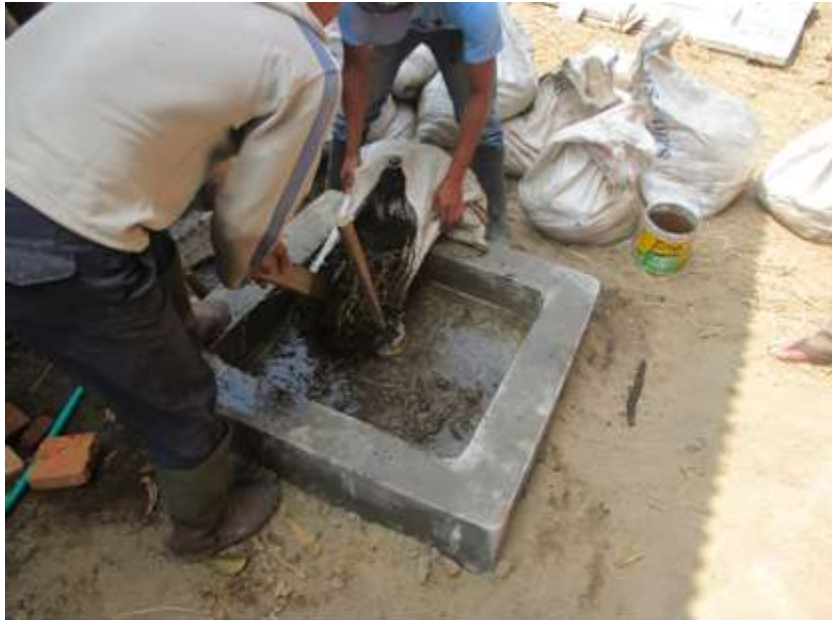
Gambar 17. Proses Pengisian Kotoran Ternak ke Dalam Reaktor sebagai Starter
