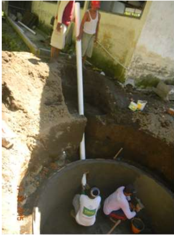
Gambar 12. Pemasangan Pipa Inlet pada Reaktor Biogas
