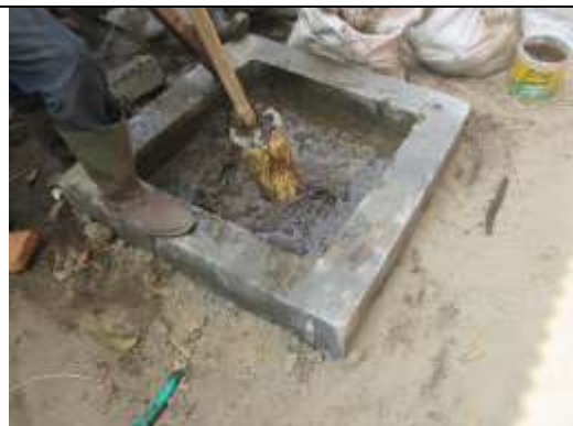
Pengisian Reaktor dengan Kotoran Sapi
