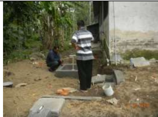
Pemantauan dan Inspeksi Bangunan Reaktor Biogas sebelum Dimanfaatkan
