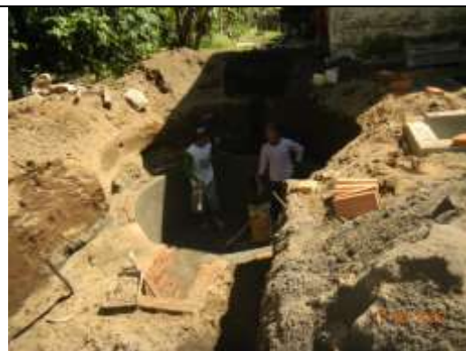
Pembuatan Reaktor Biogas di Belakang Bangunan Pabrik Pengolahan Kopi "Koperasi Buah Ketakasi."
