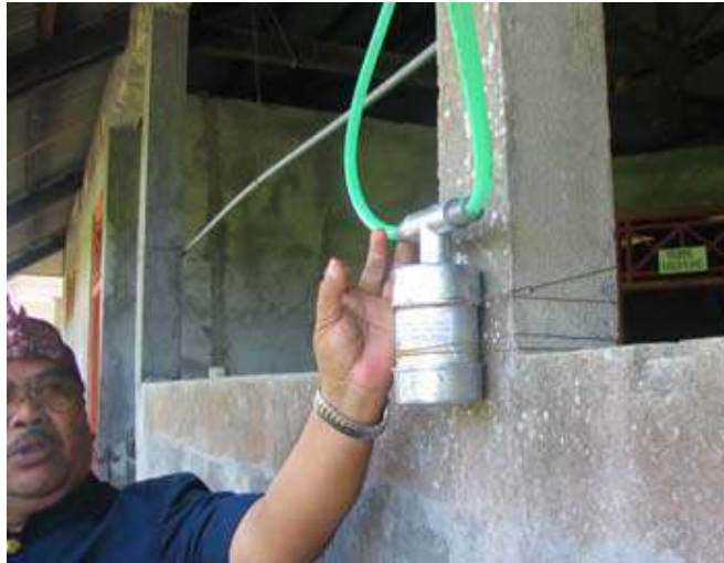
Gambar 5. Klep Pengaman Gas Sebelum Masuk ke Tabung Penampung Gas
