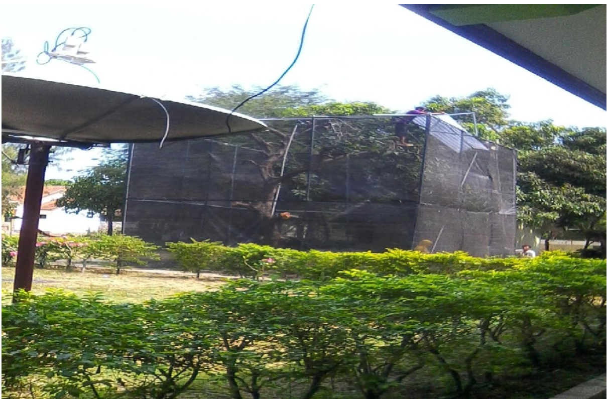
Pemasangan Atap Green House dengan Fiber Glass
