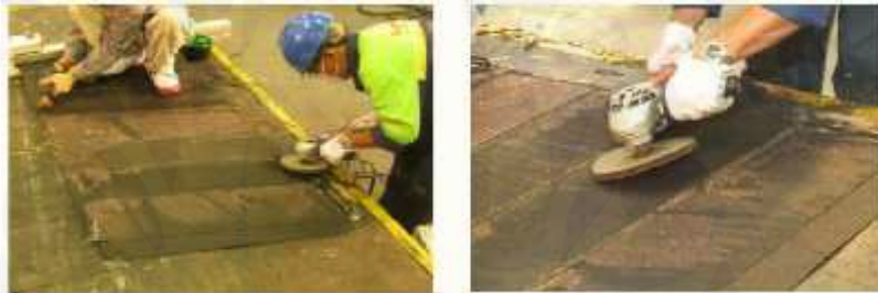
Gambar 3.16 Proses pengasaran karet yang terdapat fabric
