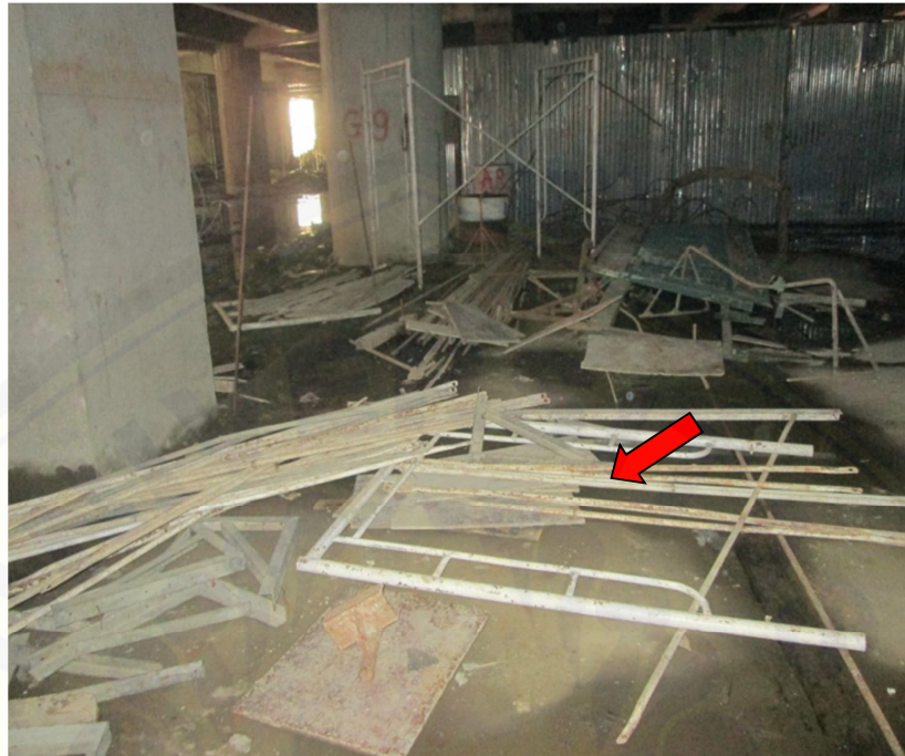
Unsafe Condition Jalan akses tidak bersih
