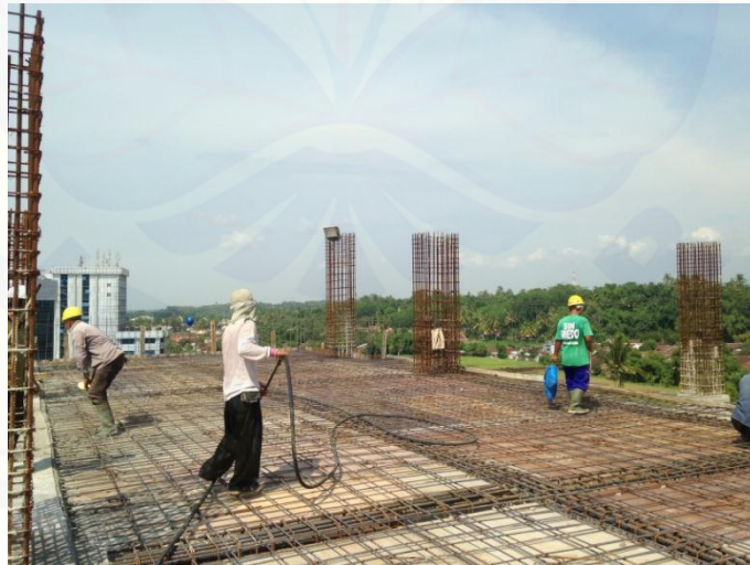
Gambar 2.2 Area kerja (balok dan plat) siap cor setelah pemasangan bekisting dan pembesian (Sumber: Hasil Pengamatan di Lapangan)
