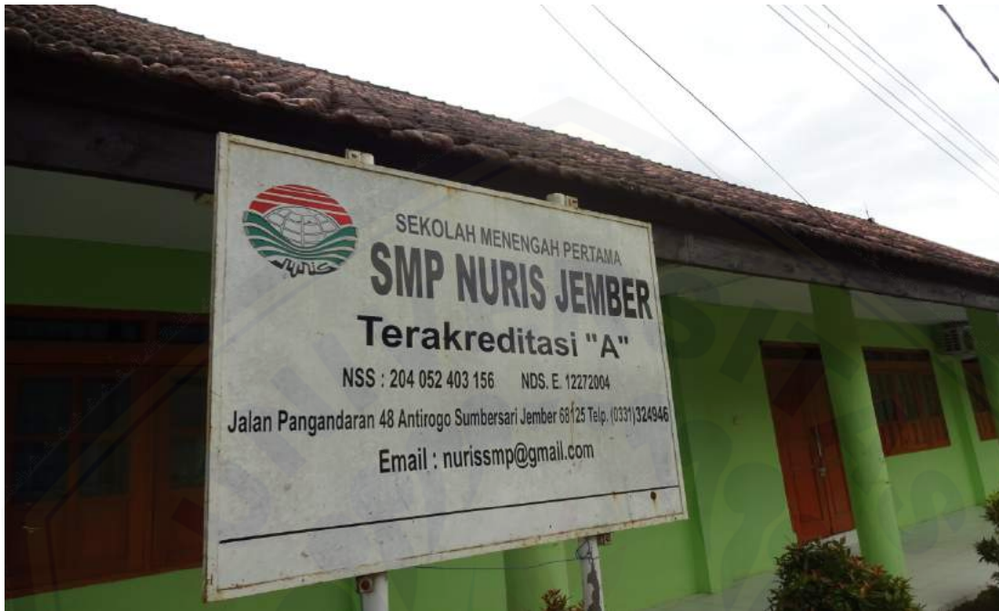
Gambar 9. Gedung SMP Nurul Islam
