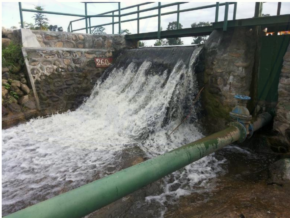
Foto Embung Sidodadi pada kondisi eksisting (tampak samping)
