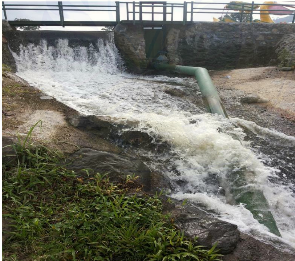
Foto Embung Sidodadi pada kondisi eksisting (tampak depan)
