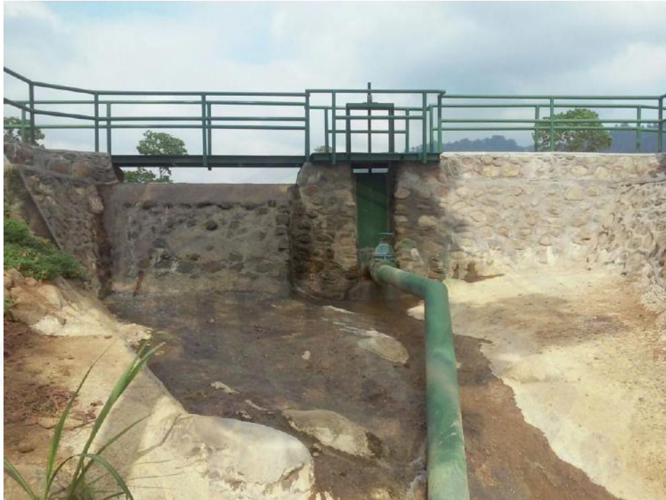
Foto Embung Sidodadi pada kondisi eksisting (tampak depan)
