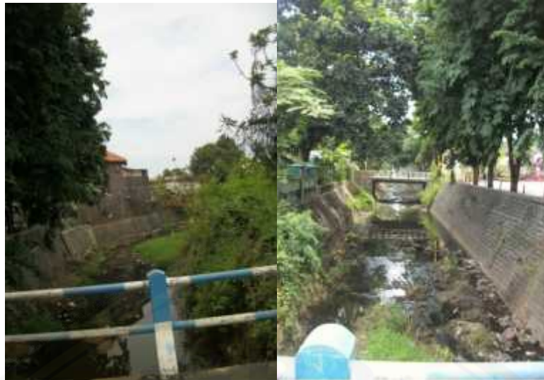
Kondisi Sungai di Sepanjang Jalan Brantas
