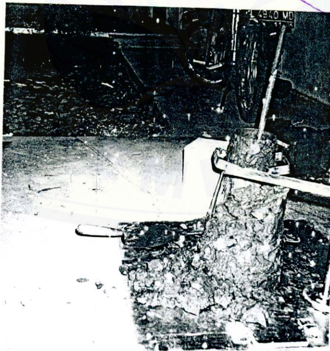
Gambar 6 : Pengujian Slump Beton
