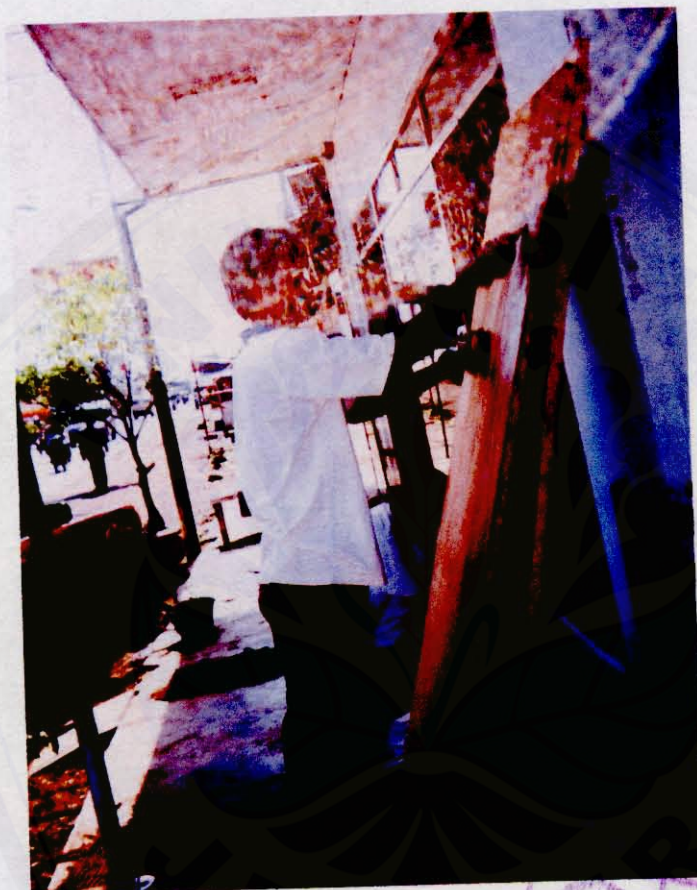
Pengecatan pintu lemari
