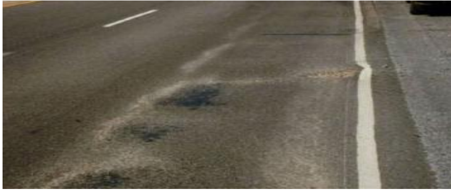
Gambar 2.26 Kegemukan ( bleeding flushing )
