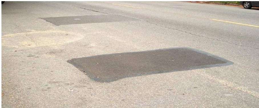
Gambar 2.27 Penurunan pada bekas penanaman ( utility cut depression )
