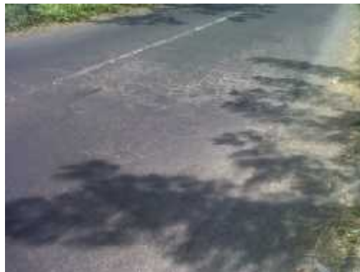
Gambar 2.2 Retak kulit Buaya
