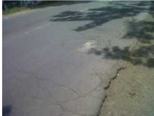
Gambar 2.3 Retak Pinggir
