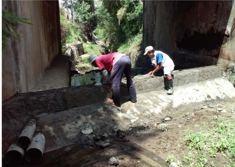
Gambar 6. Penyemenan kasar pada bendungan
