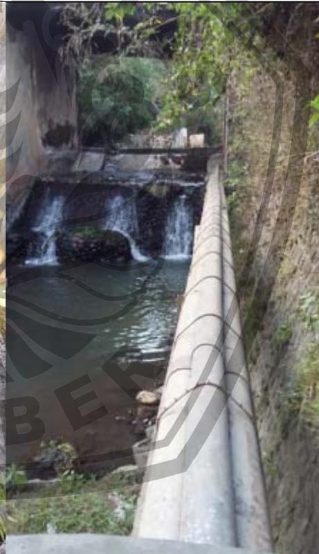
Gambar 8. Pipa saluran dari intake tempat bendungan yang ditinggikan
