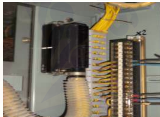
Gambar 4. Socket masih terpasang
