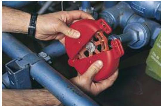
Gambar 4.2. Pemasangan Gate Valve Lockout pada Valve (Sumber: Data Sekunder Terolah, 2015)
