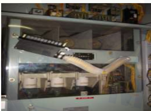
Gambar 5. Socket telah dilepas
