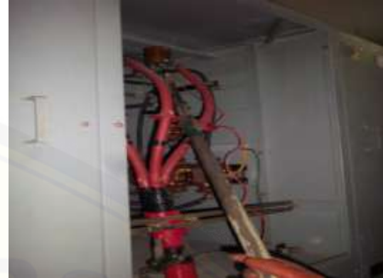
Gambar 8. Proses verifikasi energi
