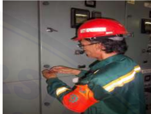
Gambar 2. Persiapan isolasi energi
