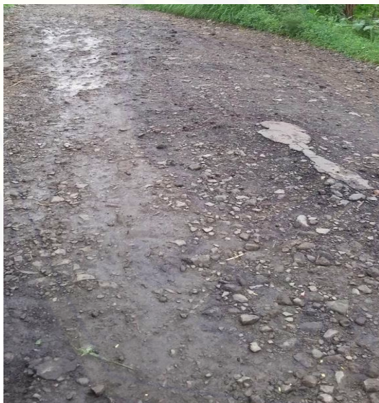
Gambar 4.13 Akses Jalan Makadam
