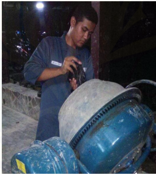
Gambar 4.1 Proses pencampuran material.
