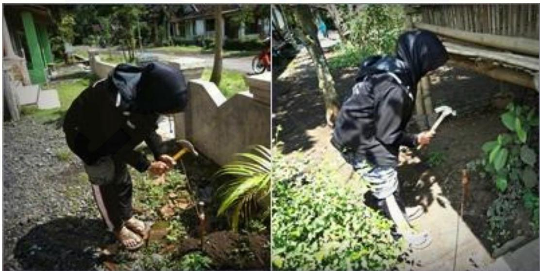
Gambar 8. Penginjeksian elektroda ke dalam tanah
