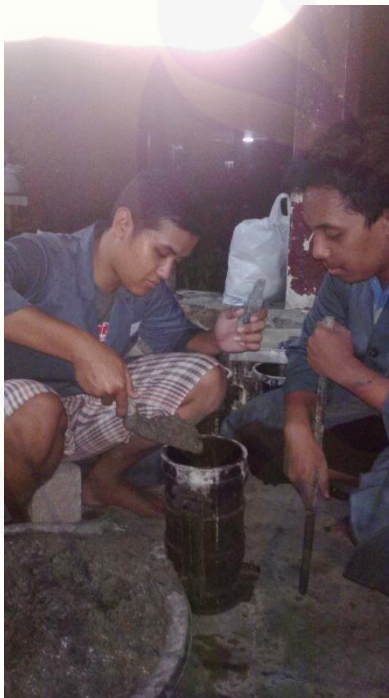
Gambar F.7 Memasukkan material ke bekisting
