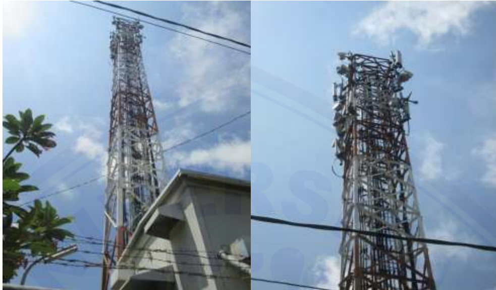
Gambar 4.2 tampilan fisik menara Site PSRANGANTBGMD
