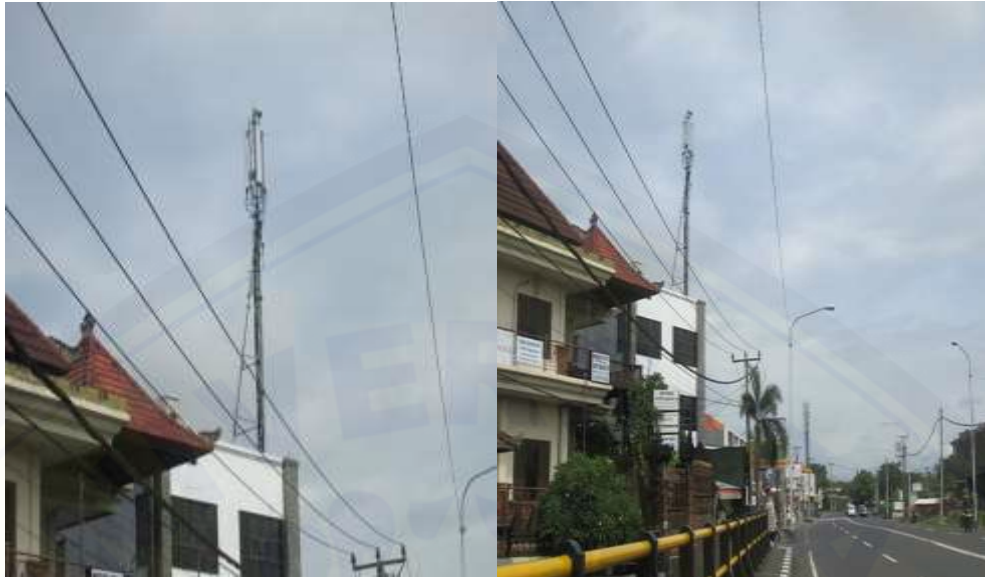
Gambar 4.4 tampilan fisik menara Site TTCRENONID
