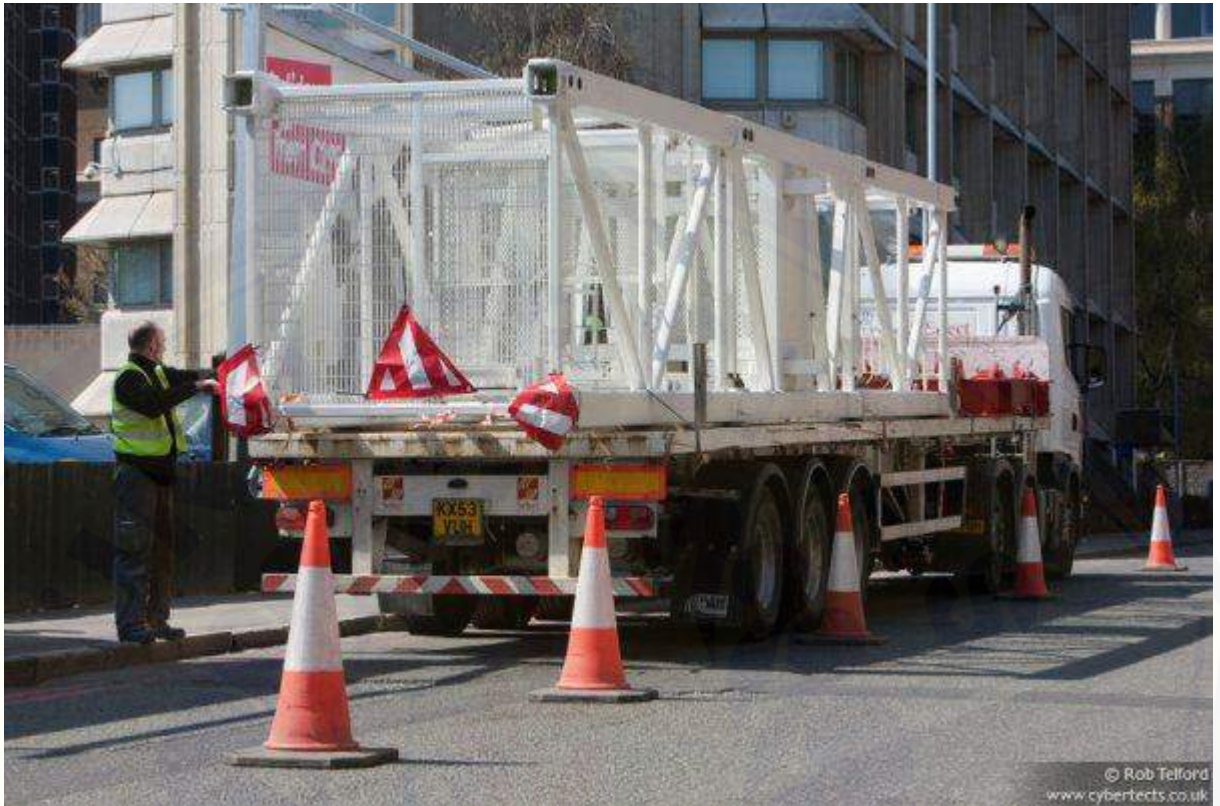
Gambar 4 Mobilisasi segmen Tower Crane dengan Trailer ( from : skyscrapercity.com )
