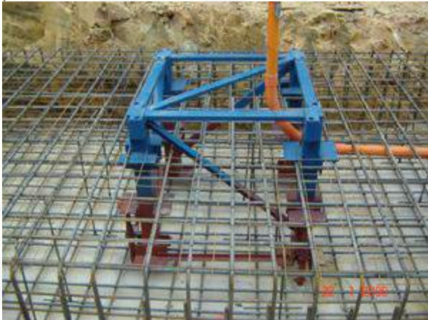
Gambar 1 Fondasi Tower Crane sebelum
