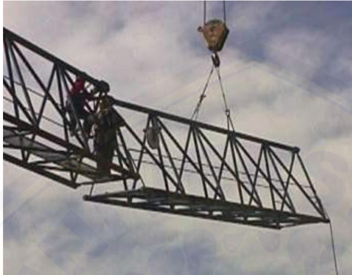
Gambar 7 Pemasangan Jib
